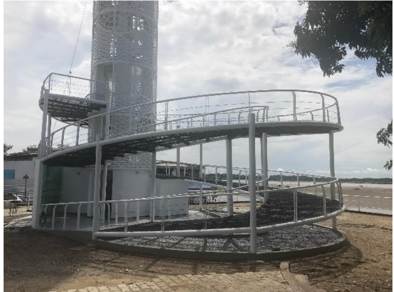
Foto 2: Rampa de acceso en estructura metálica
