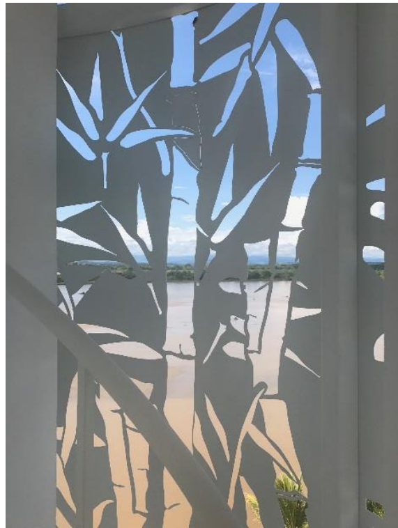
Foto 18: textura de lámina perforada de fachada
