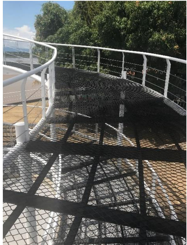
Foto 14: Rampa de acceso en estructura metálica
