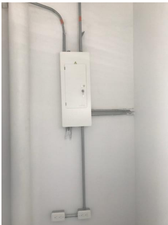
Foto 9: Tablero de control de instalaciones eléctricas
